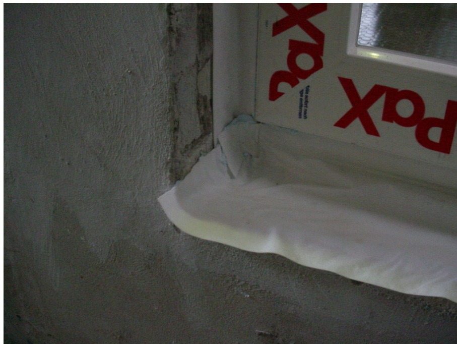
Bild 2 Abdichtung der äußeren Anschlussfuge mit 4W-Band Außen. Verklebung zur Leibung mit 4W-Haftkleber. Im unteren Bereich seitlich wannenförmige Ausbildung der Abdichtung.
