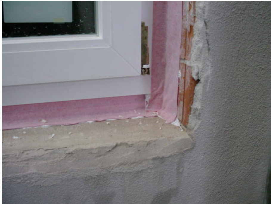
Bild 5 Raumseitige Fugenabdichtung im unteren Bereich.
