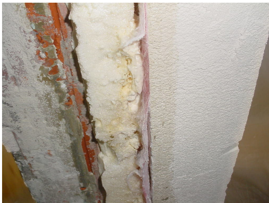
Bild 8 Abschließende Untersuchung der Anschlüsse. Fenster bereits ausgebaut. Gute Haftung des Putzes auf der Vliesbeschichtung der 4W-Bänder.
