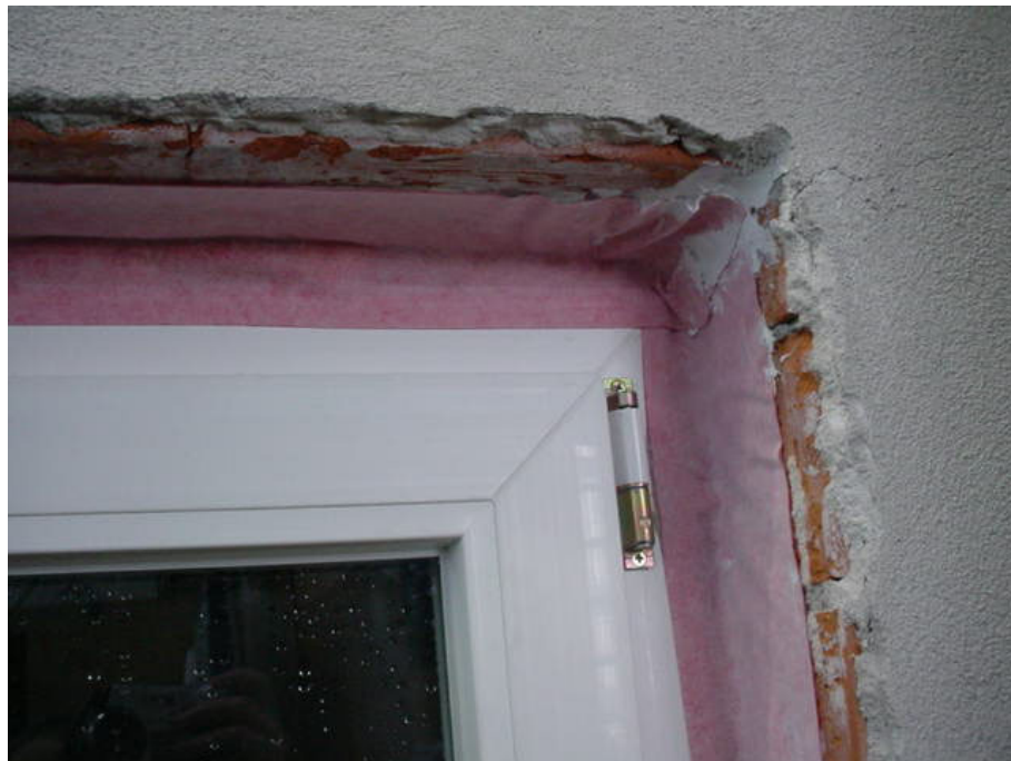
Bild 4 Abdichtung innen mit 4W-Band Innen. Verklebung zur Leibung mit 4W-Haftkleber. Eckausbildung oben.
