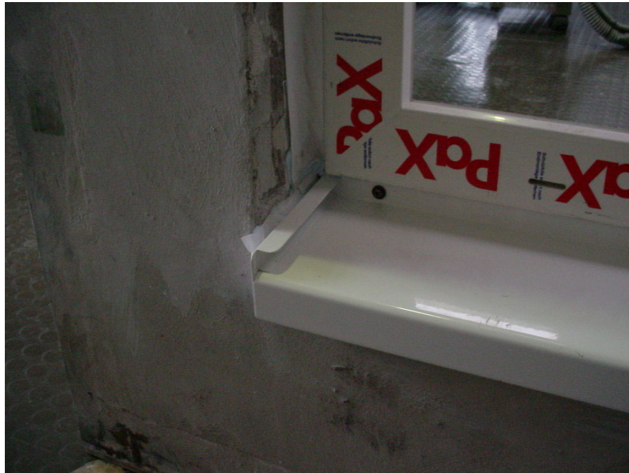
Bild 3 Eckdetail nach Montage der Außenfensterbank.
