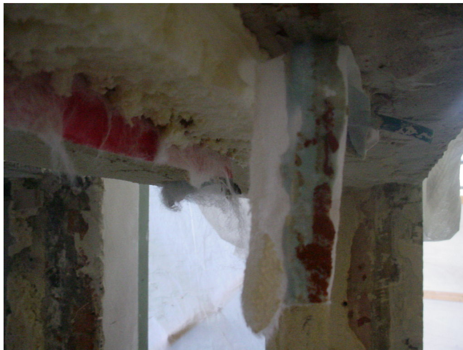
Bild 7 Abschließende Untersuchung der Anschlüsse. Fenster bereits ausgebaut. Gute Haftung der Verklebung (4W-Haftkleber) zum Untergrund.
