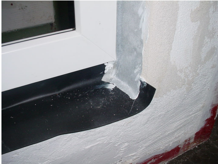
Bild 3 Im unteren Bereich Ausbildung einer Folienwanne mit BTI Diffband EPDM. Überlappende Ausbildung im Eckbereich.
