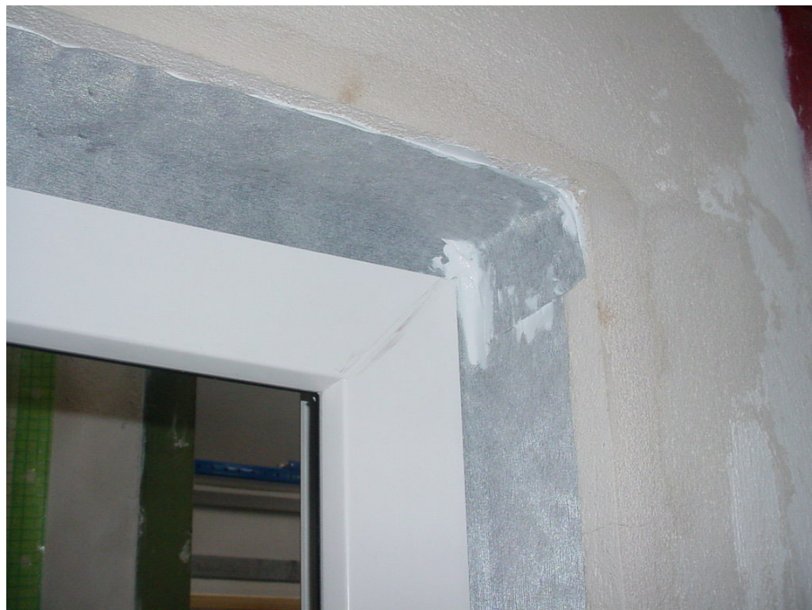
Bild 2 Abdichtung der äußeren Anschlussfuge seitlich und oben mit 4W-Band Außen. Verklebung zur Leibung mit 4W-Haftkleber.
