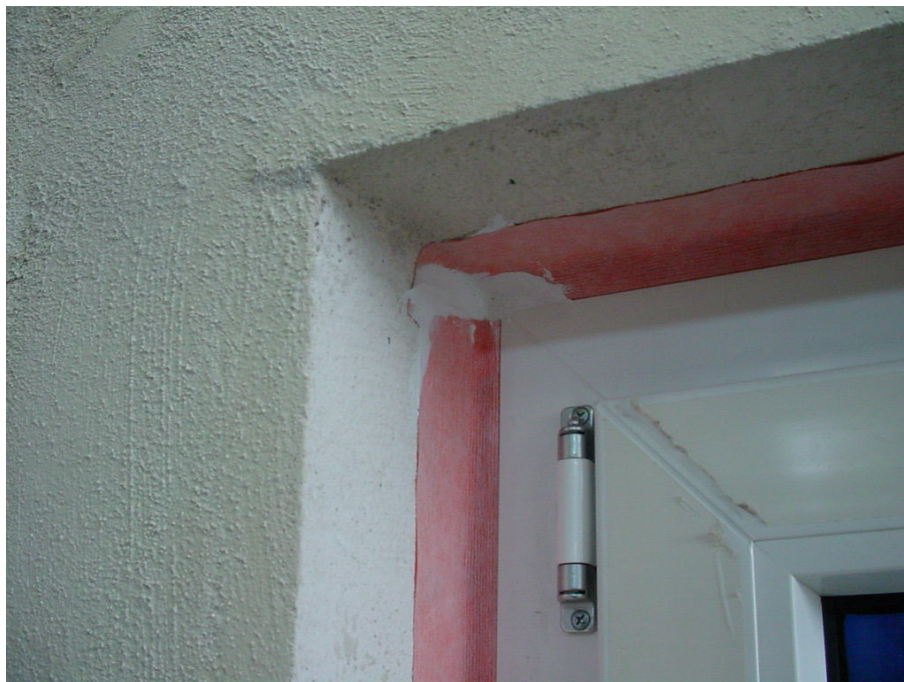
Bild 4 Abdichtung innen seitlich und oben mit 4W-Band Innen. Verklebung zur Leibung mit 4W-Haftkleber. Eckausbildung oben.
