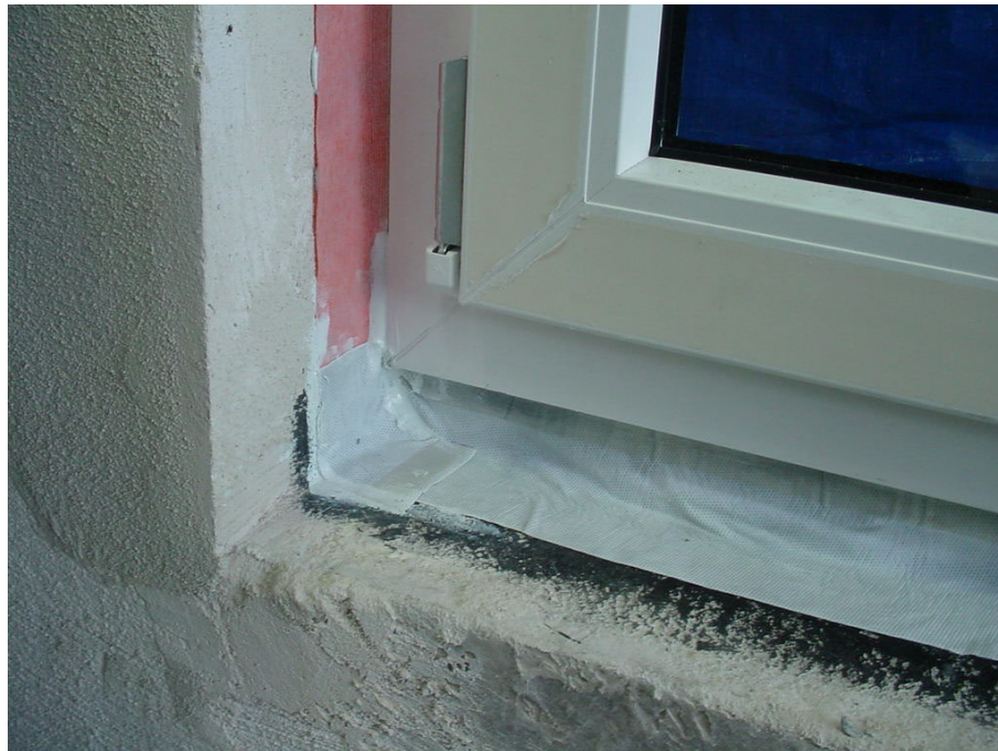
Bild 5 Im unteren Bereich Abdichtung mit 4W Vliesbutyl. Haftflächen mit BTI Multi-Primer vorbehandelt. Überlappende Ausbildung im Eckbereich.
